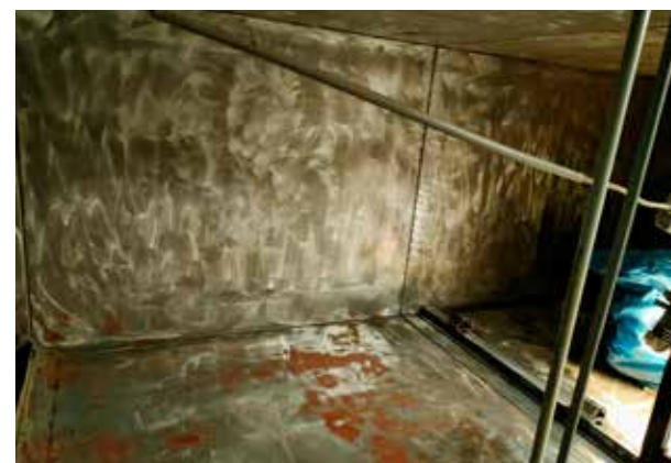
De wanden, deuren, vloerdelen en constructiedelen zijn geschuurd.
